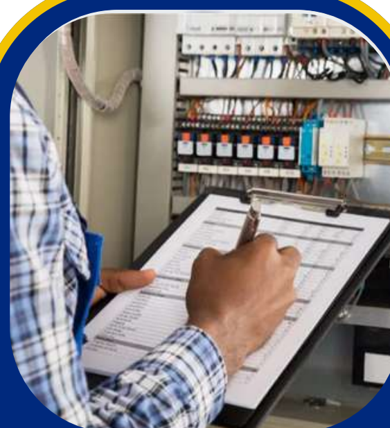
Protección contra incendios (PCI)
