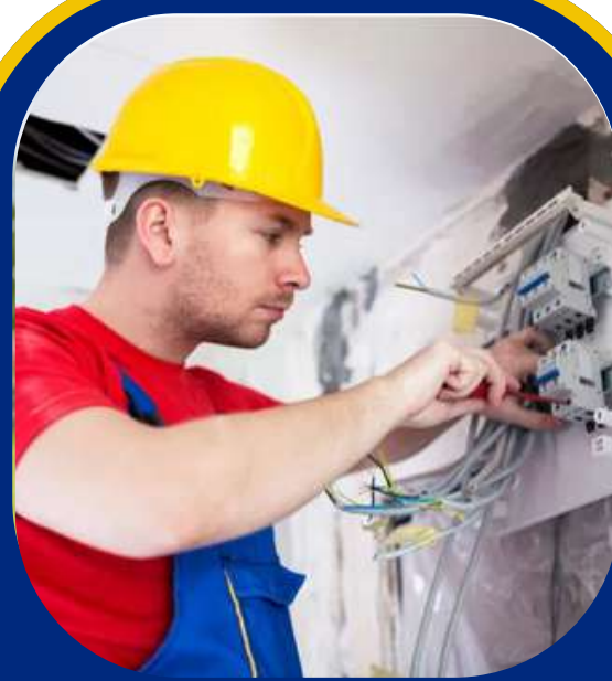
Media y baja tensión
